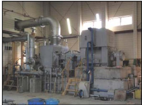
蒸気タービンと発電機(1200kW)
